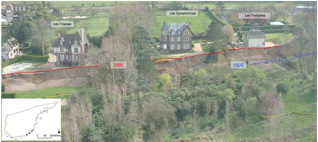
Figure 6-19. Positions de l'escarpement principal en 1995 et 2001 au droit des propriétés Les Troènes, Les Symphorines et les Préfailles du glissement des Fosses du Macre à Cricqueboeuf (Photo : DREAL Basse-Normandie, avril 2001).
