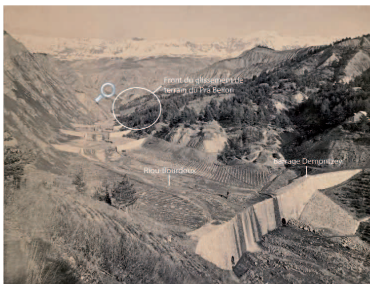
Figure 105. Barrage de Demontzey en 1891. En rive gauche du torrent du Riou Bourdoux, il est possible d'apercevoir le front du glissement de terrain du Pra Bellon. Le détail montre une surface remaniée et totalement dénudée.
