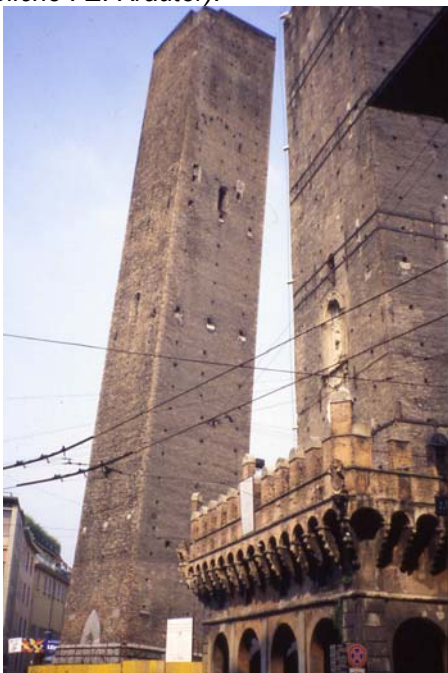
Photo 2.7 : Basculement d'un campanile lié au tassement par consolidation de terrains compressibles, Bologne, Italie (1997).
