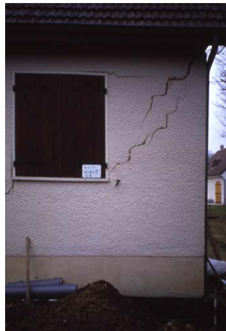
Photo 2.8 : Lézardes d'un pavillon liées au retrait du sol argileux en période de sécheresse, Orléans, France (1993).
