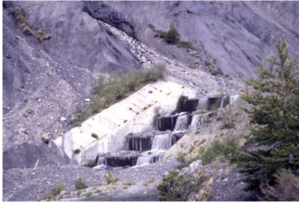
Photo 5.3 : Barrages de correction torrentielle dans le Riou Bourdoux, Barcelonnette, 1987.
