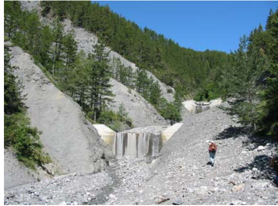
Photo 5.4 : Deux barrages de correction dans le torrent de Faucon de Barcelonnette, juillet 2002.
