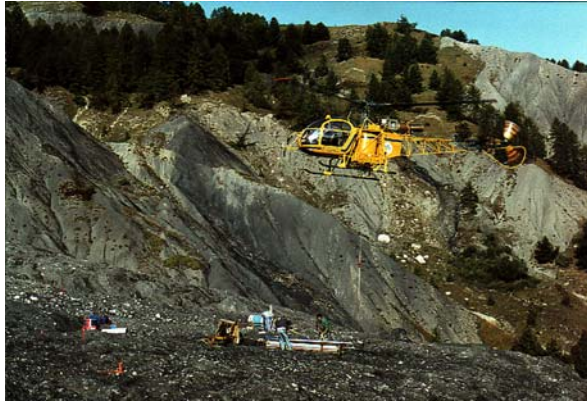
Photo 5.9 : Hélicoptage de la sondeuse Nuzi sur le profil C (juillet 1996).
