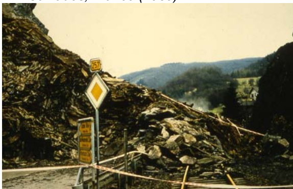
Photo 2.5 : Eroulement rocheux d'un volume de 5 000 m 3 sur une voie ferrée près de Kreuzberg, Rheinland-Pfalz, Allemagne (Cliché : E. Krauter).
