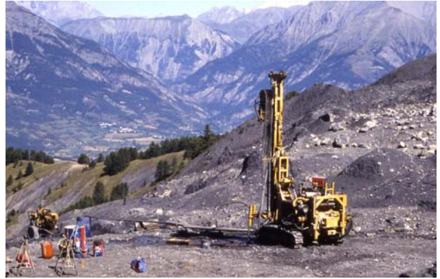
Photo 5.10 : Sondeuse Nuzi en place sur le profil A. Vue vers l'Est (juillet 1996).
