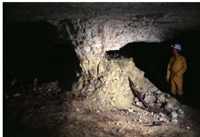
Photo 1.6 : Carrière dans le tuffeau (Tours). Risque d'effondrement en raison de la dégradation du pilier (1989).
