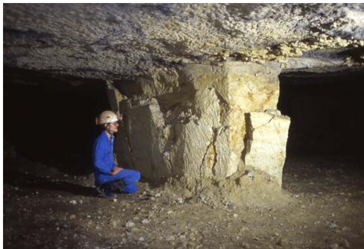
Photo 1.7 : Carrière dans le tuffeau (Tours). Risque d'effondrement en raison du foudroyage du pilier (1989).
