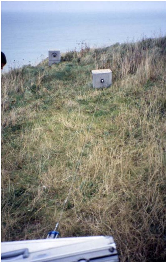
Photo 4.1 : Fissuromètre à fil Invar de part et d'autre de fractures ouvertes le long des falaises du Cap Blanc Nez, Pas-de-calais, France.
