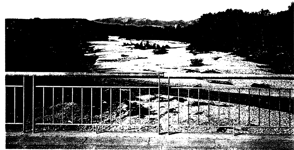
Photographie 5 - La bande active de l'Ouvèze à l'amont du pont de Sablet.
