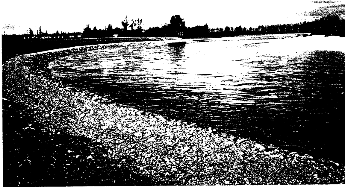
Photographie 36 - L'enrochement de Taffanelles, une protection de berge coûteuse et en cours d'affouillement (commune de Saint-Jean-de-Niost, rive droite de l'Ain).
