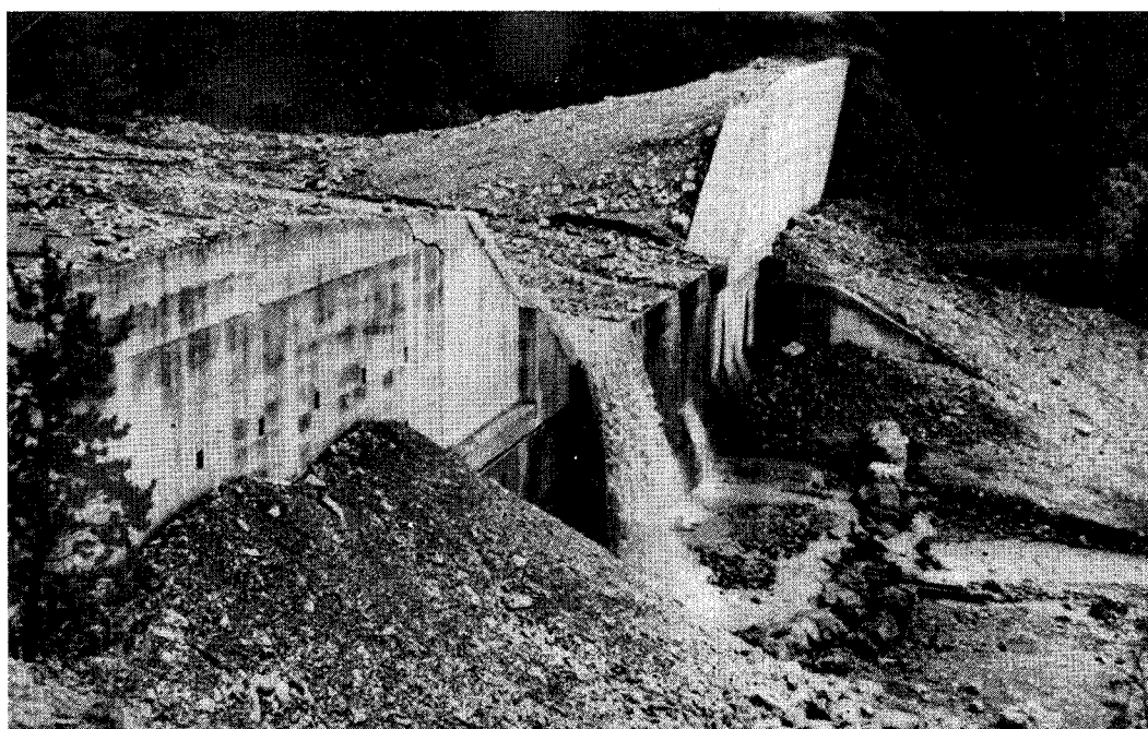
Photo 10 : Seuil bétonné dans le Riou Bourdoux
