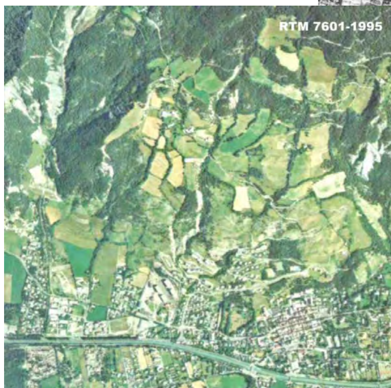
Photos n°2, 3, 4 Vues aériennes de l'Adroit.
