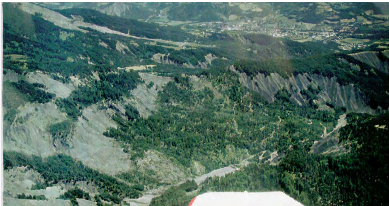
Photo n°1 – Vue du glissement de Pra-Bellon – Delsigne, 1999.
