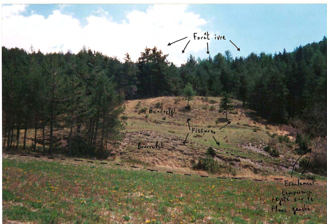
II 8 : Partie amont du glissement de Lans : bourrelets d'accumulation à la base d'une coulée (marnes noires remaniées) relativement récente. Forêt perturbée, écoulement rejeté sur le flanc gauche de la coulée.
