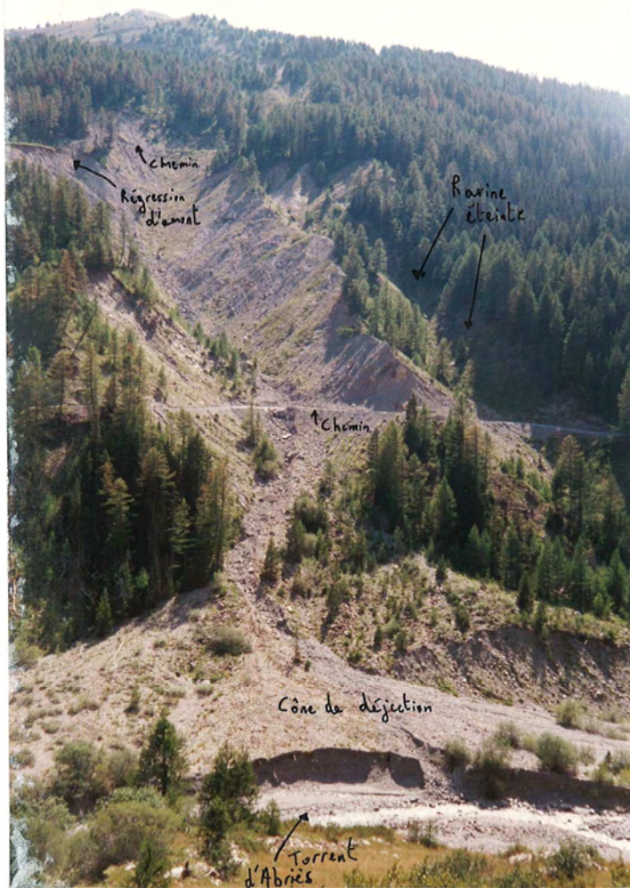
II 7 : Le Combalas : Ravine sur 400 mètres de long et 100 de large dans la couverture morainique. Noter, le cône de déjection (épaisseur : 3 mètres) entaillé par le torrent d'Abriès.
