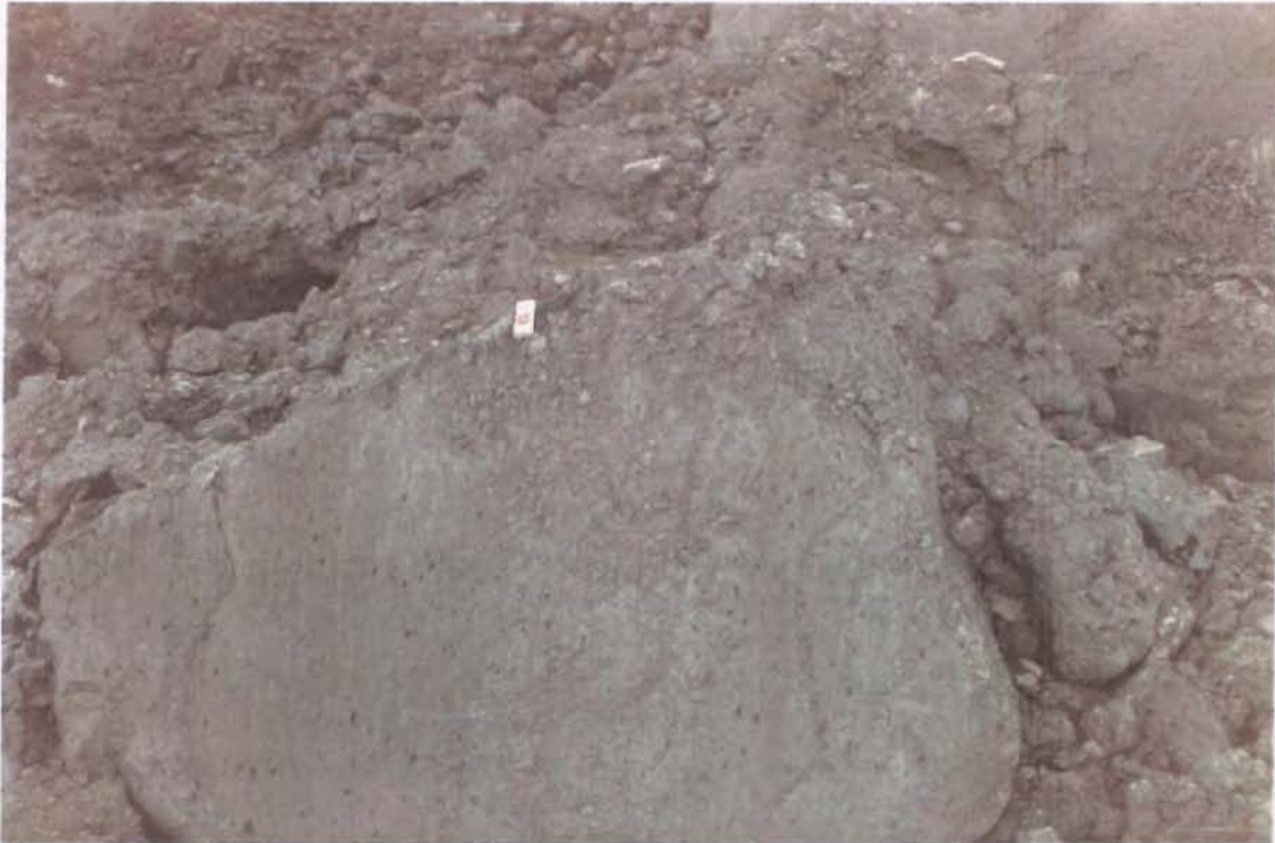
Photo 10 : Fissuration d'un panneau marneux du replat supérieur (tranchet A).
