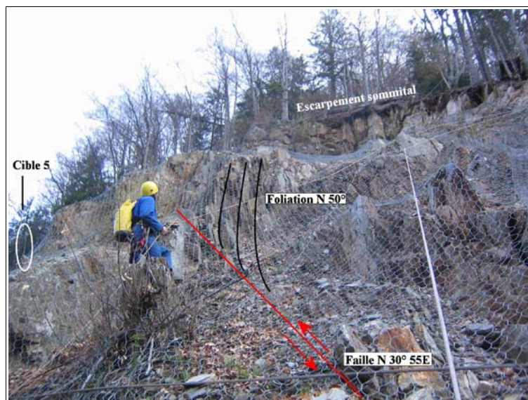
Figure II.9 : Faille N 20-30° affectant la foliation et sur laquelle se développe l'Arly.
