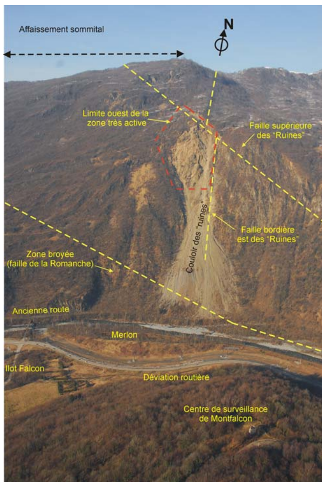
Fig. 7 Vue de face du versant instable et des enjeux dans la vallée. le passage de la faille de la Romanche est marqué par une zone broyée
