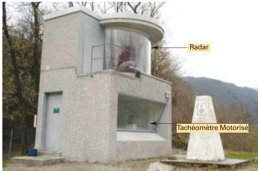
Local de mesures situé à Montfalcon
