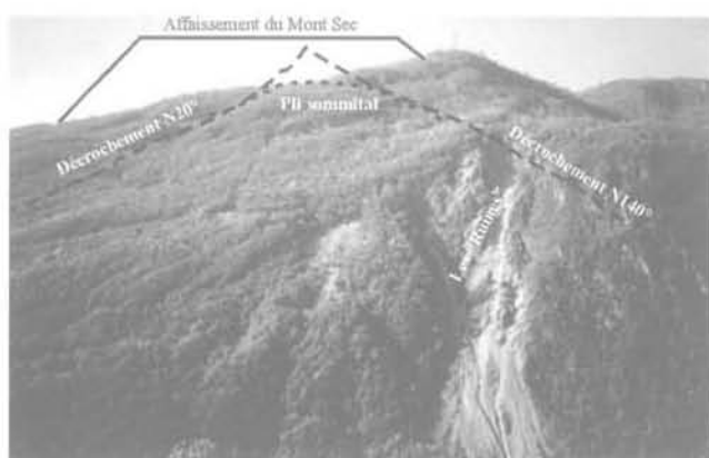
FIG. 9 Vue du couloir des « Ruines » et de l'affaissement du Mont Sec. View of the « Ruines » corridor and « Mont Sec » subsidence.
