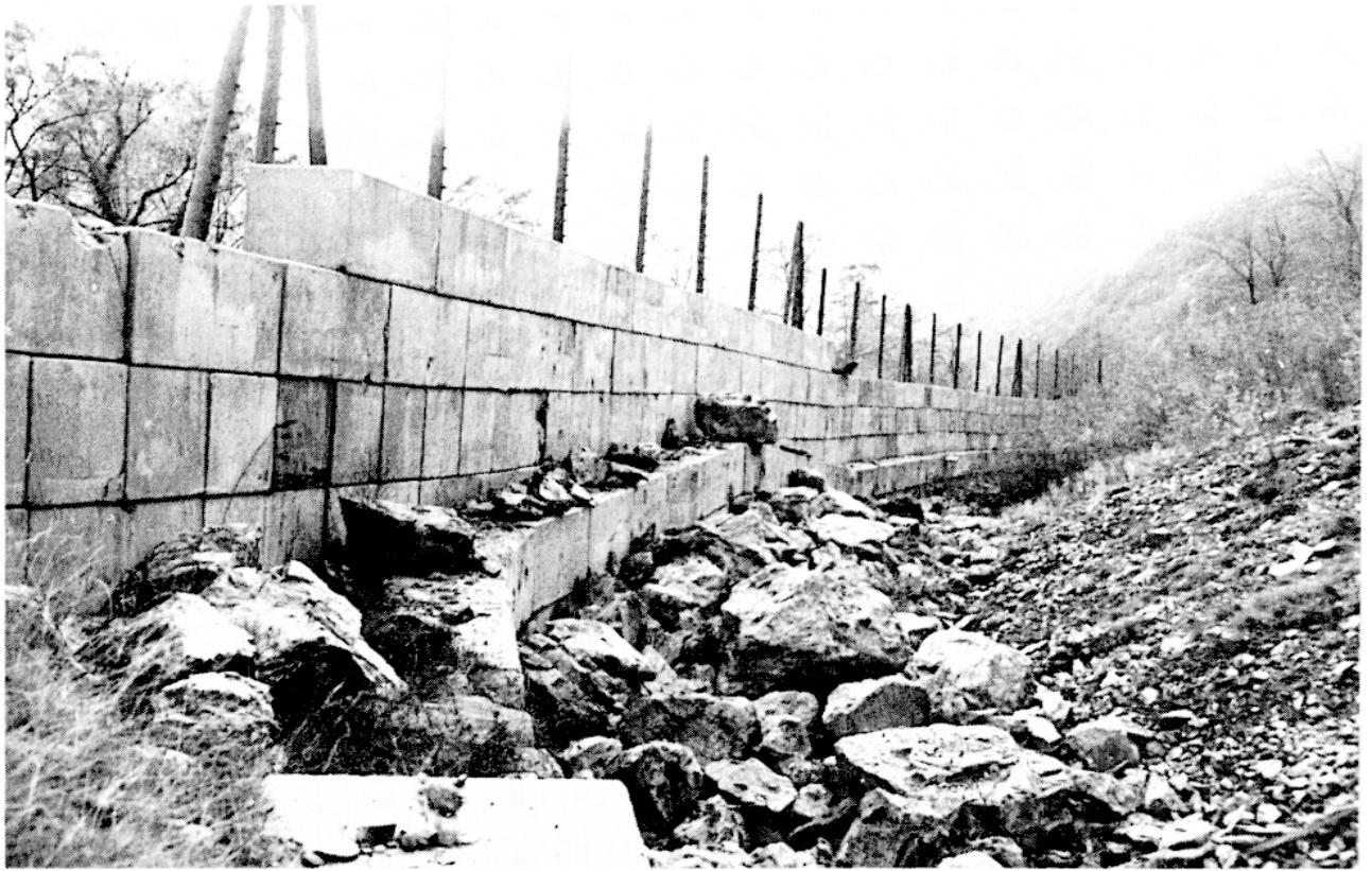
Photo 3. — Le mur de protection de l'ancien tracé de la N. 91 et les blocs d'ébouilisation accumulés contre celui-ci, au pied du talus. Certains ont franchi cet obstacle. La dimension des blocs leur donne quelquefois un volume approchant le mètre cube. Photo prise le 17 novembre 1987.
