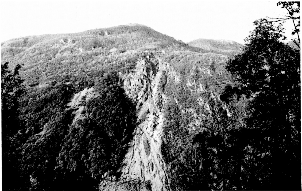
Photo 2. — Eboulement de Séchilienne vu du versant opposé le 17 novembre 1987. Cette photo de la partie haute fait apparaître l'importance des zones disloquées en voie d'ébouilisation et le rôle du ruissellement.
