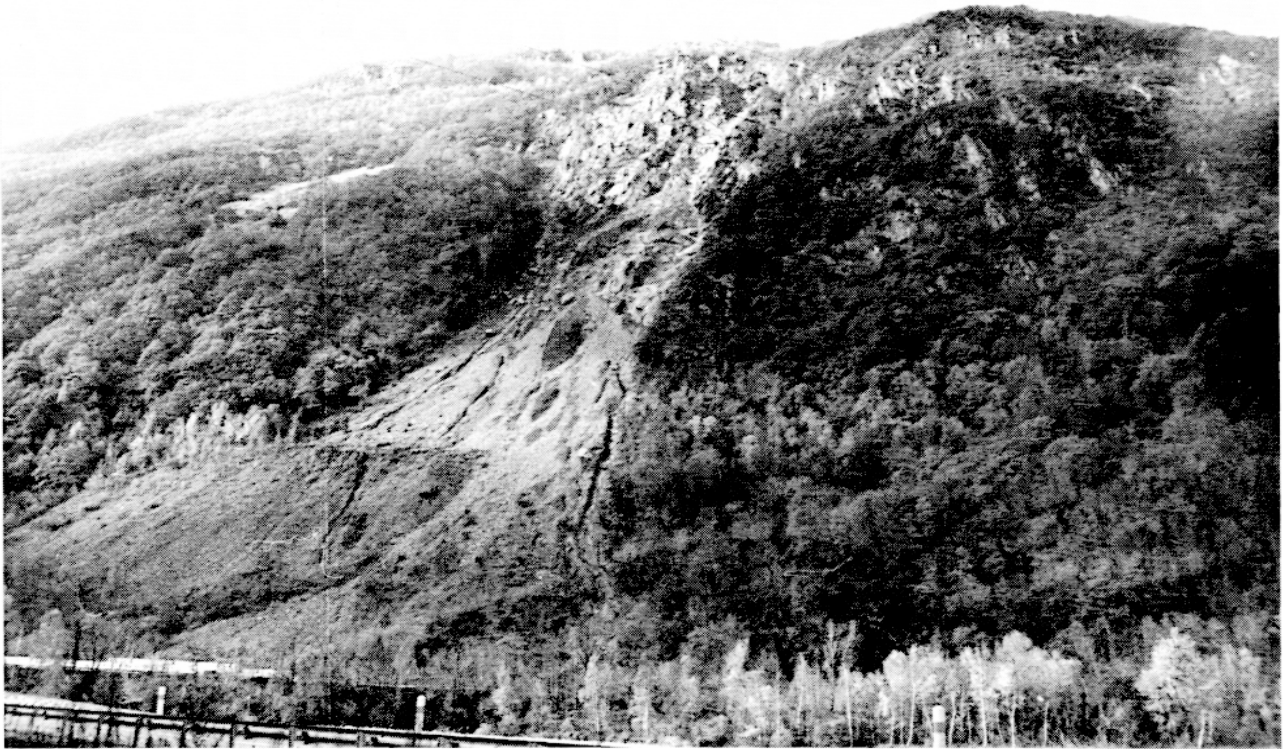
Photo 1. — Vue générale de l'éboulement des Ruines à Séchilienne, 17 novembre 1987 depuis la déviation de la N. 91. On distingue la partie haute rocheuse en voie de désintégration et le talus d'ébouilisation sillonné de ravines d'écoulement. A gauche, la tache claire (zone déboisée) est le secteur en voie d'ébouilisation rapide et d'évolution accélérée.
