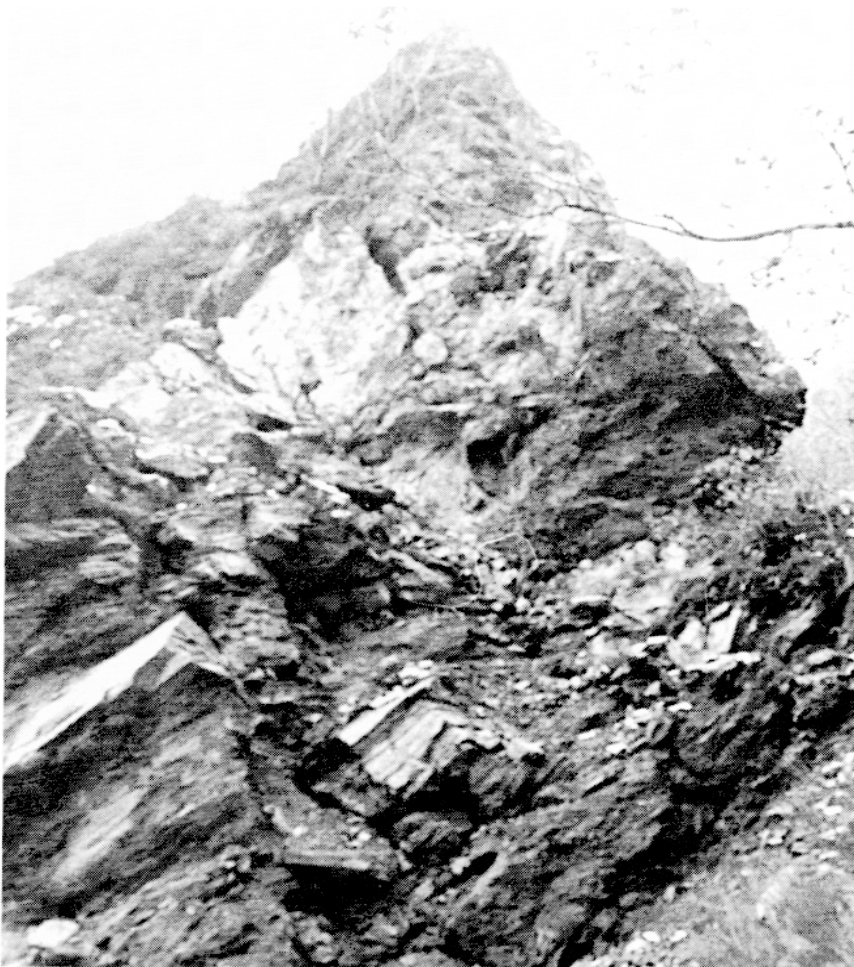
Photo 4. — Le sommet du versant en voie d'ébouilisation : bloc détaché du front du replat, ouvert par des fissures, soutirage des eaux de pluie, intense désagrégation météorique (gel/dégel, ruissellement, chutes de pierres très fréquentes, écroulements limités).
