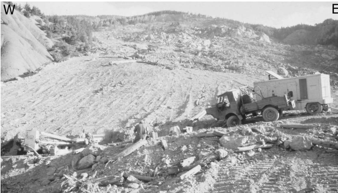
Figure 4-16. Vue des travaux de remodelage et de drainage entrepris sur la partie en glissement (cliché RTM).
